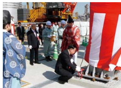
【立柱式】川崎バイオマス発電(株)戸川社長による「ナット締め」の儀
