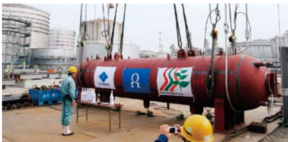
【ドラム場】ドラムは、発電設備のパーツとしては最も重量があり川崎バイオマス発電の場合、32トンあります
